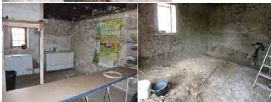
Réhabilitation de la "salle des machines" au Change. Décembre 2010 et janvier 2011
